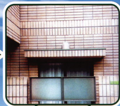
洗浄・施工後
